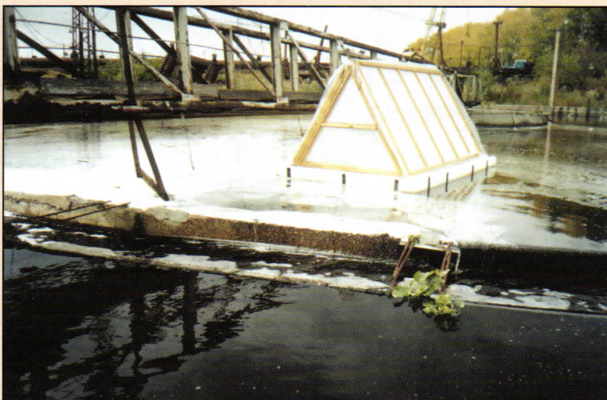
Рис. 2. Парник с эйхорнией прикреплен к ферме и медленно движется с ней по отстойнику (октябрь: t^{\circ}_{\text{воздуха}} = 15 + 16^{\circ}\text{C} , t^{\circ}_{\text{сточной воды}} = 20 + 22^{\circ}\text{C} ).
