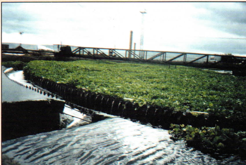
Рис. 1. Радиальный отстойник диаметром 40 м. Эйхорния заполнила практически всю поверхность. На переднем плане виден зубчатый перелив осветленной воды, на заднем плане — ферма с приводом (начало октября: t^{\circ} воздуха = 2 + -5 °С, t^{\circ} сточной воды = 25 °С)
